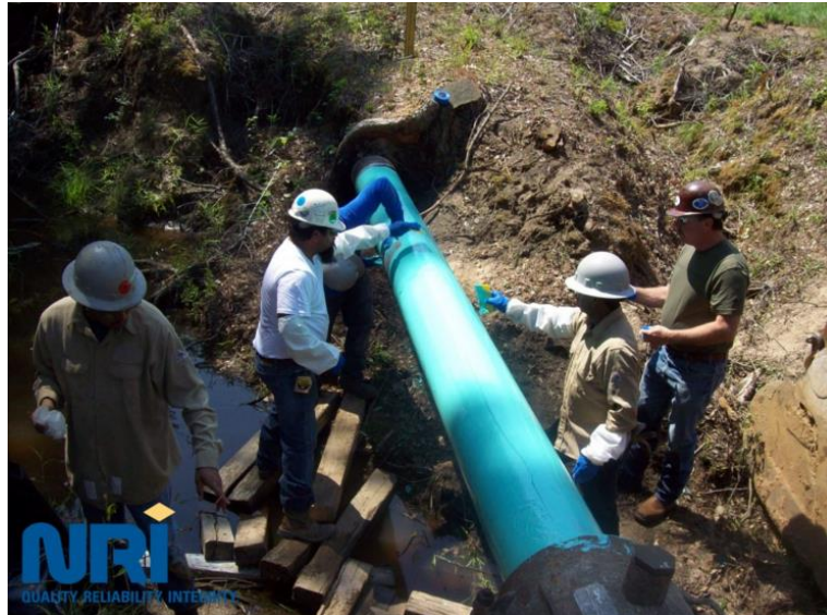
Figura 12: Reparo em tubulação com o adesivo Syntho-Subsea TM LV Epoxy (retirado do site do fabricante).
